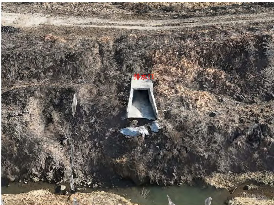
图 2.4-5 溢洪道现状图
