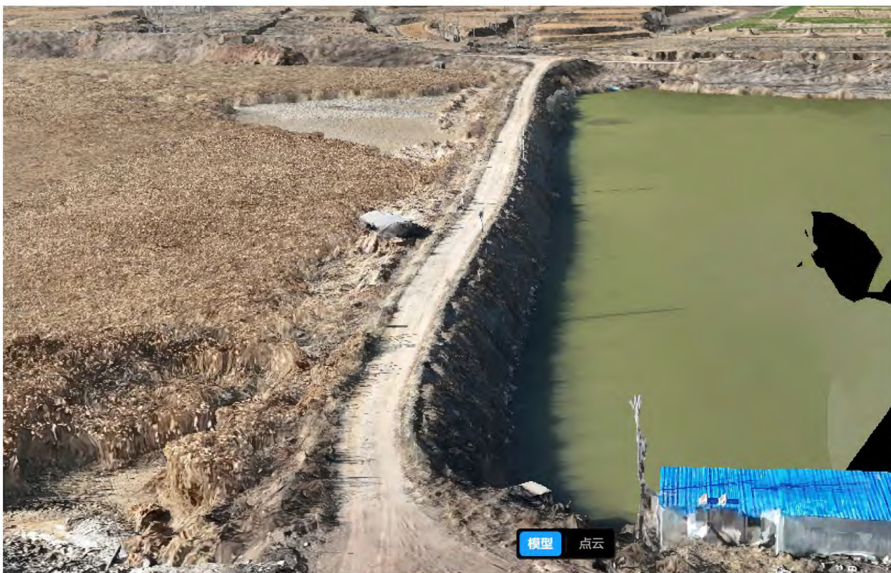
图 2.4-3 北侧拦水坝现状图
